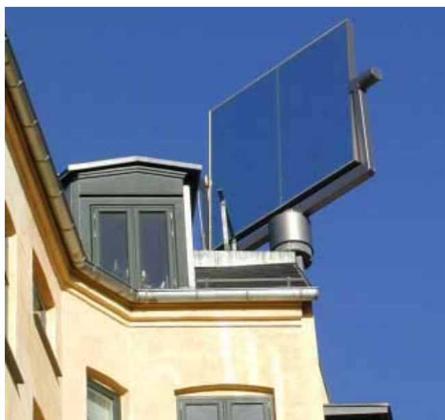
Heliostat : optimisation de la lumière naturelle
