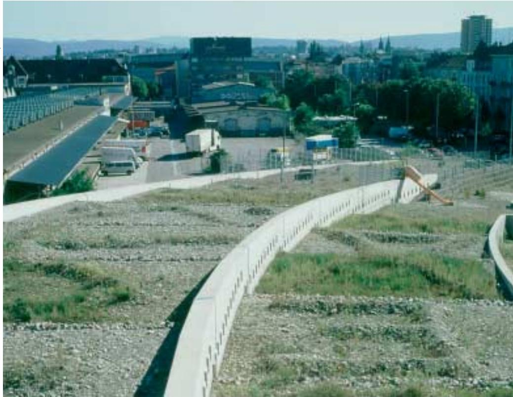
La fonctionnalité de toitures vertes richement structurées et composées de divers mélanges de substrats est examinée sur la toiture de l'autoroute à Bâle.
