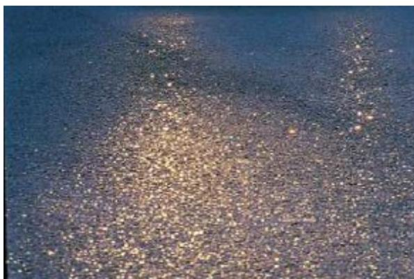
Grâce à ses propriétés photométriques cet enrobé scintillant permet de différencier visuellement certaines parties de la chaussée par rapport aux zones recouvertes d'enrobé traditionnel. En attirant l'attention de l'utilisateur et en le guidant, l'enrobé scintillant permet de sécuriser les carrefours, les traversées piétonnes ou les espaces dédiés aux modes doux.
