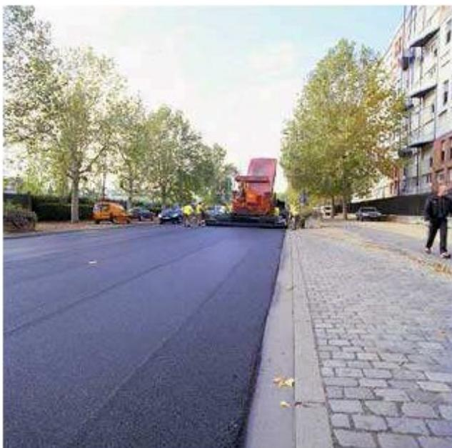
Utilisation de béton bitumineux 0/10 sur les chaussées
