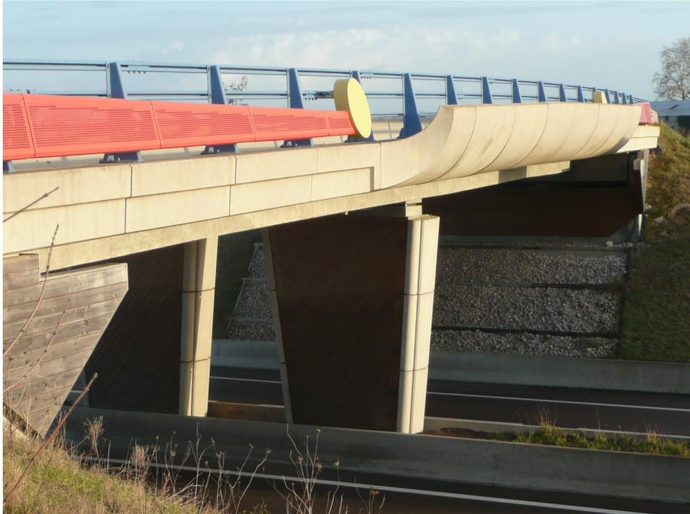
*Ouvrage existant – Au centre les piles intermédiaires traitée avec du bardage bois et au fond les perrés traités partiellement en lit de cailloux et bardage bois*
